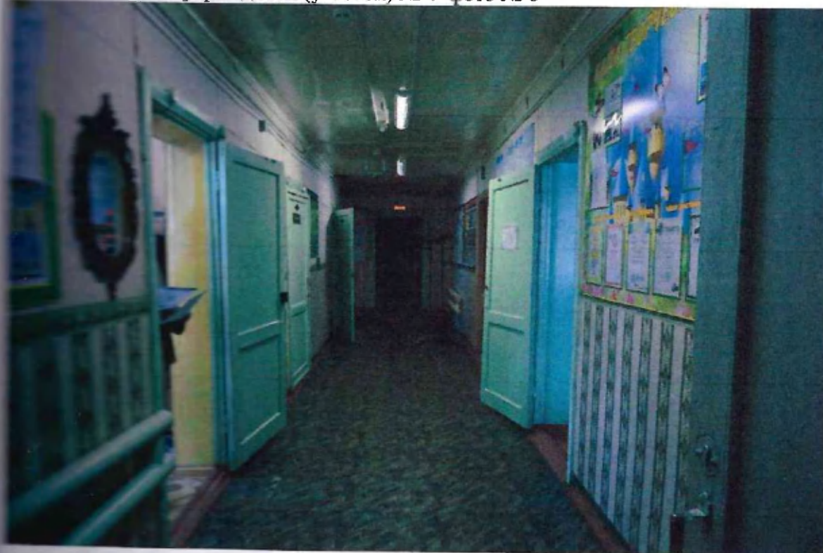
внутри здания (участок) № 4 фото № 6
